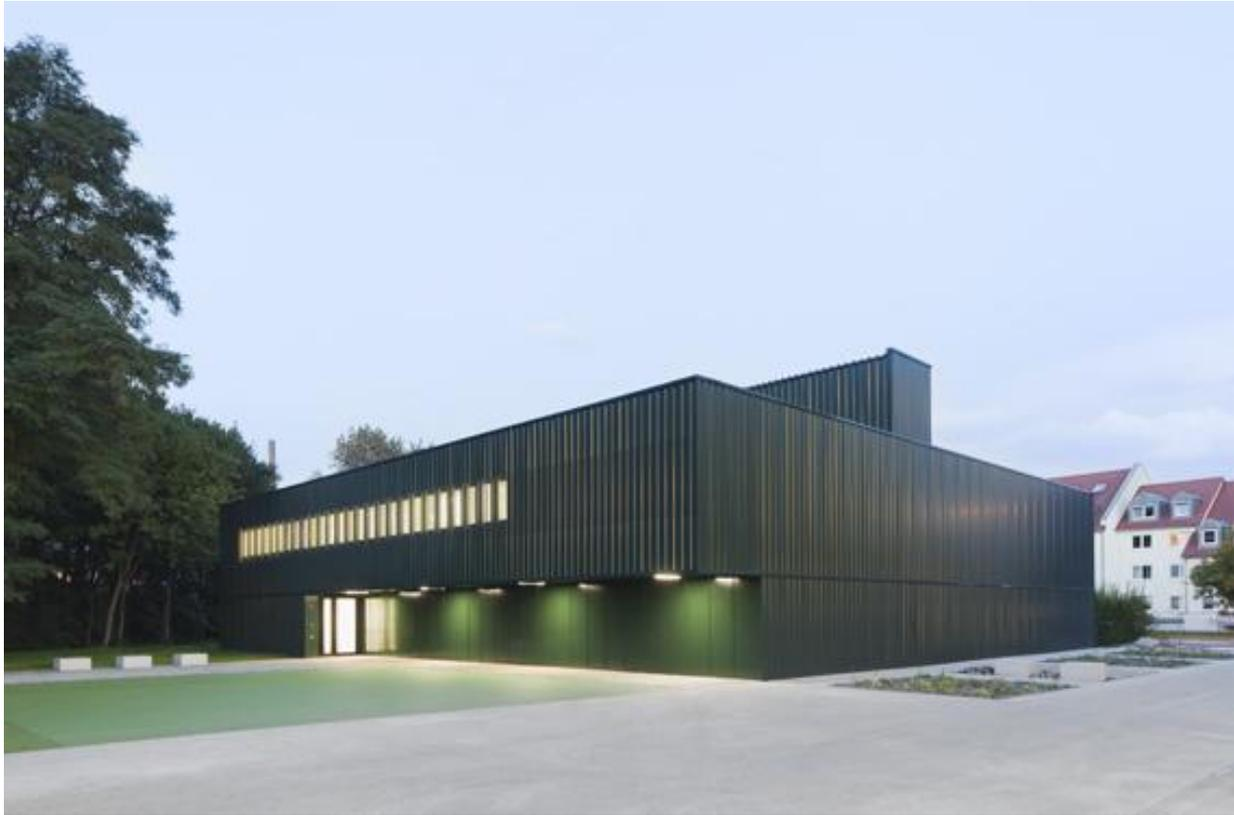
*Die Fassade der preisgekrönten Sporthalle ist mit grünen Aluminium-Trapezprofilen von Laukien bekleidet. Durch Lochungen im oberen Bereich fällt Tageslicht in die Räume. (Foto: Werner Huthmacher. Eingeschränktes Nutzungsrecht durch den Fotografen: Das Bildmaterial darf lediglich, unter Nennung des Fotografen, zur Illustration von Produktberichten, die direkt im Zusammenhang mit diesem Objekt stehen, verwendet werden.)*
